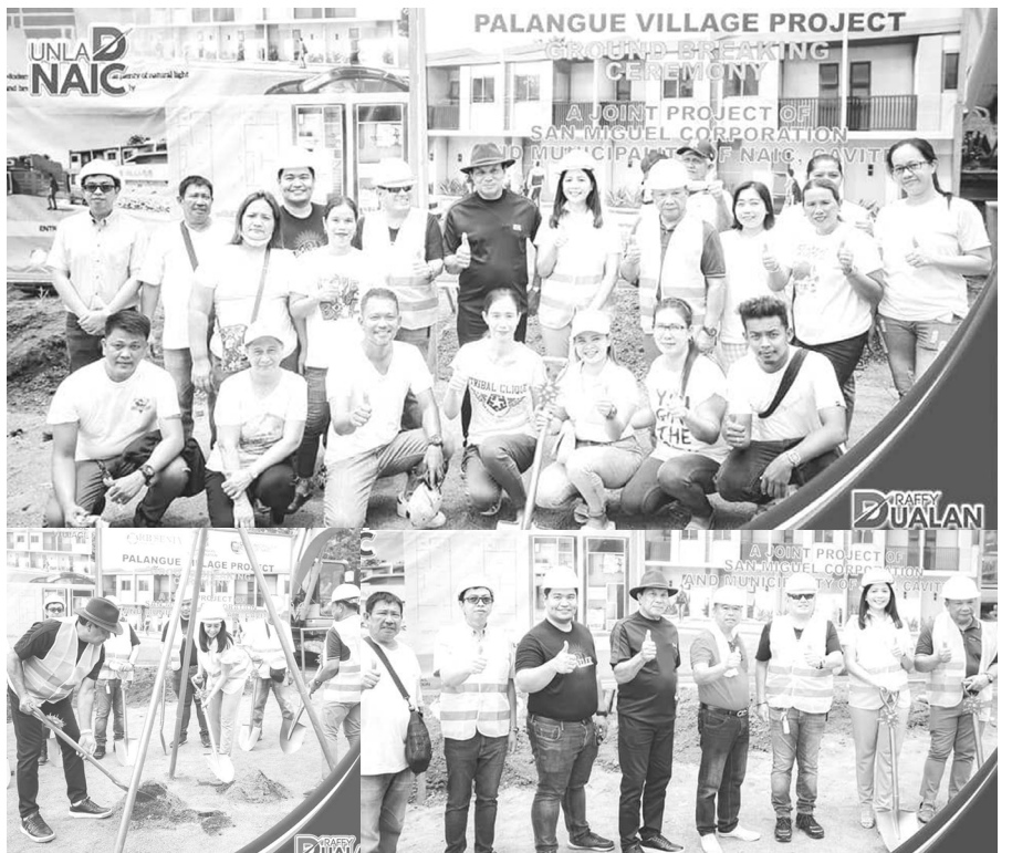
Sa isinagawang Joint Project ng San Miguel Corporation, Municipality of Naic at RB Senia Development Corporation pormal ng isinagawa ang Ground Breaking Ceremony para sa itatayong bagong Palangue Village Project sa ating Bayan.
