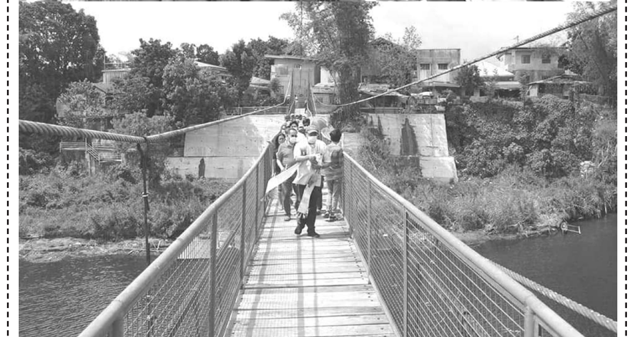
Opisyal ng binuksan ang Hanging Bridge na nag-uugnay sa Poblacion at Pinagsanhan sa Maragondon, Cavite.
