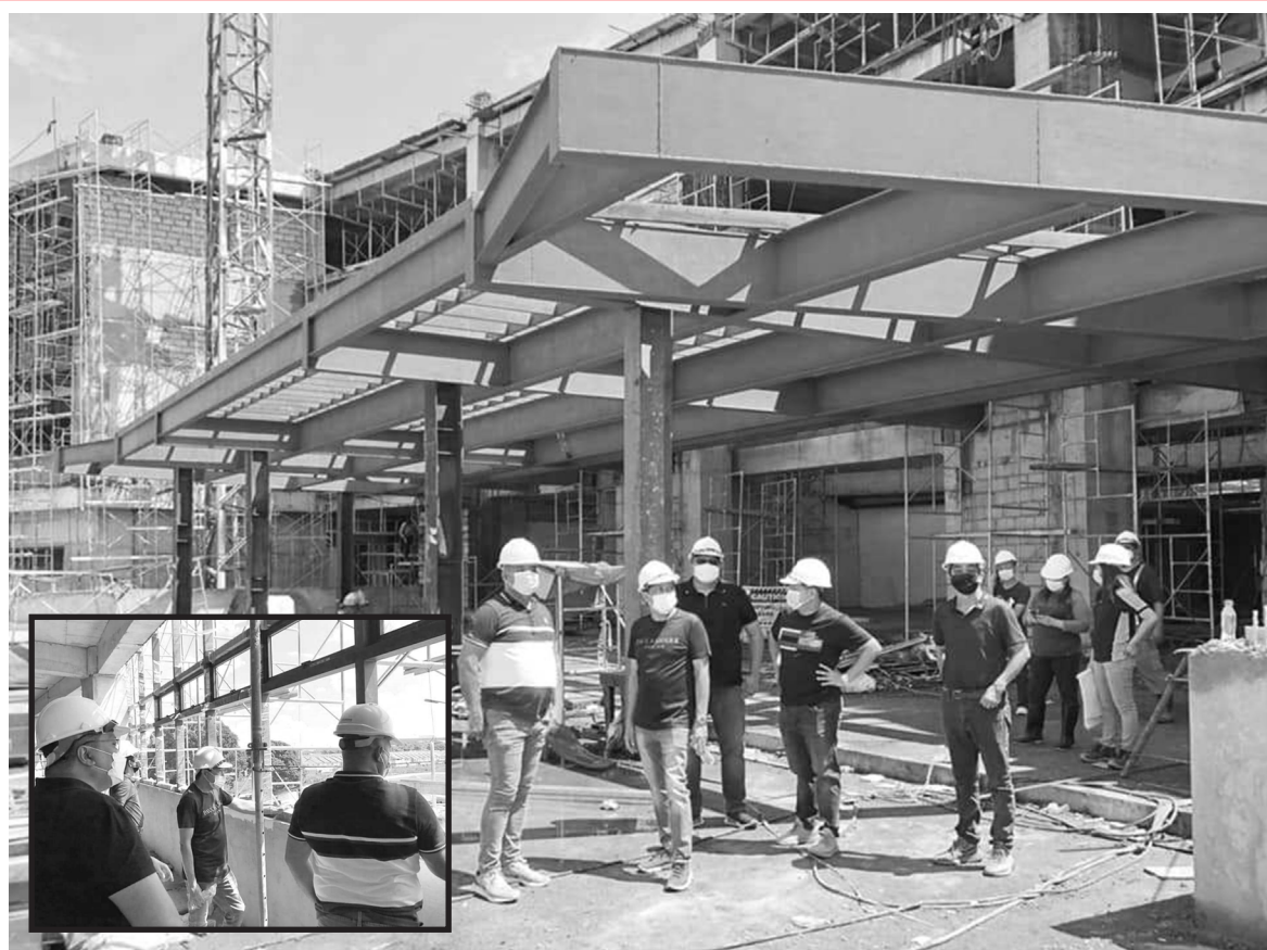
Binisita ni Vice Mayor Ony Cantimbuhan ang magiging tahanan ng Pamahalaang Lungsod ng Imus sa hinaharap. Sa ngayon ay nasa tamang takdang iskedyul ang pagawain at inaasahang magagamit ito bago matapos ang taon. Kasama natin sina City Engineer Chris Sarno, City Architect Roel Saquilayan at iba pang mga kawani ng lungsod sa pagpunta dito.
